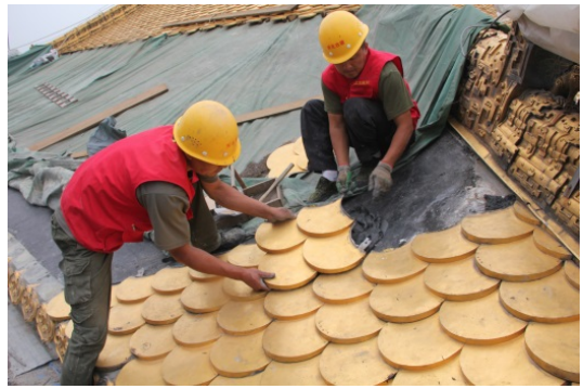
图3 安装金瓦
