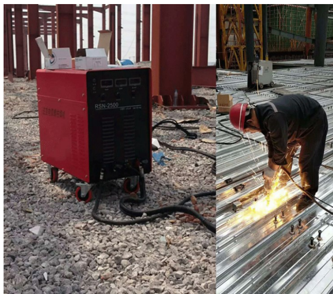
图2 电弧螺柱焊机现场作业图
