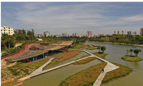
(海口美舍河湿地科普馆建成照片 摄影师: 李季)
