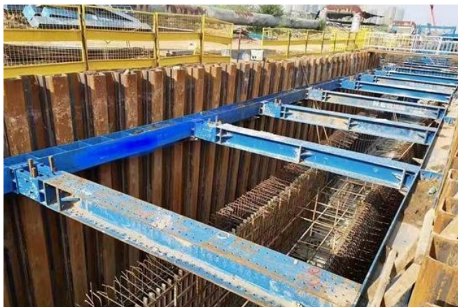
图2 围檩施工现场
