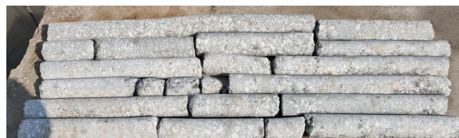
图4 注浆处理后抽芯图片
