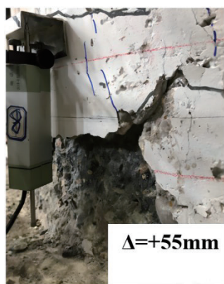
图3 东面S4柱混凝土
