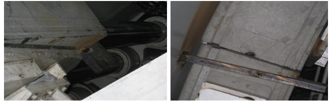
图2 型钢固定示意图
