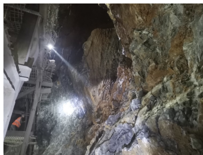
图5 小田坝隧道左幅K50+269揭露竖斜向溶洞
