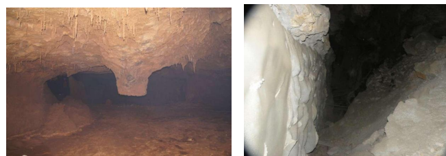
D1K760+901拱部右侧溶蚀大厅
