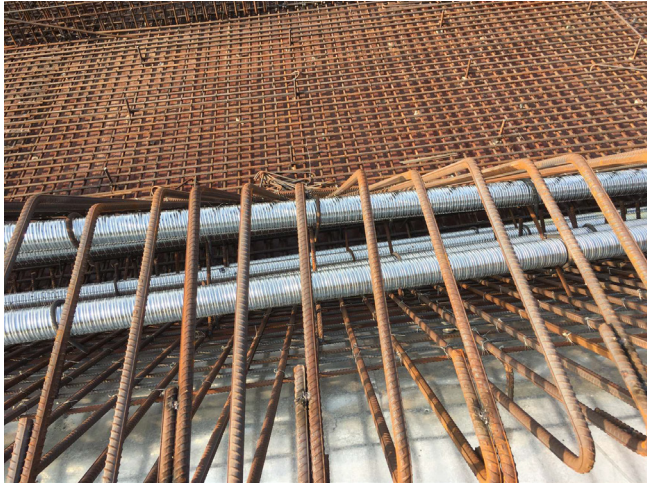
图为箱梁腹板波纹管
