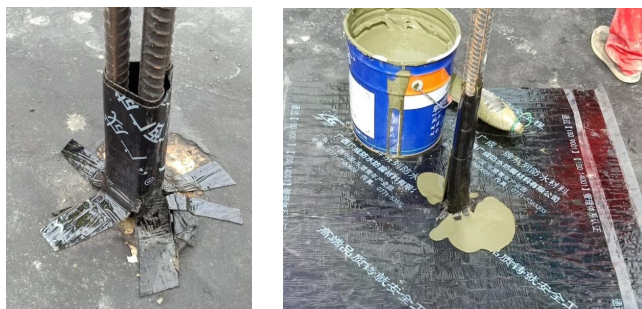
图4 现场紧裹锚杆钢筋安装图。
