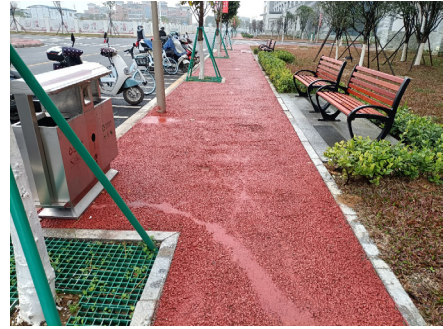
图6 透水混凝土实景图
