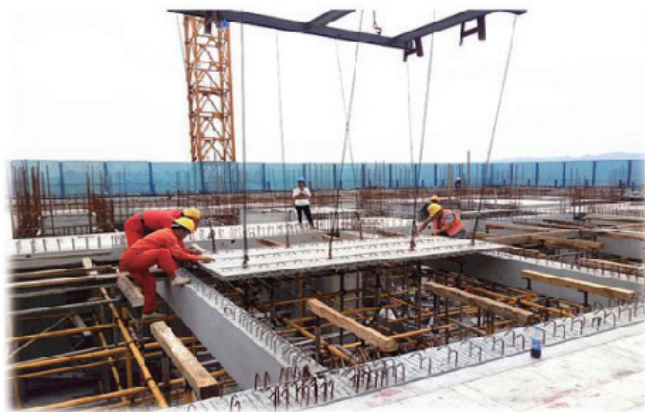
图3-1 陇枕停车场施工现场
