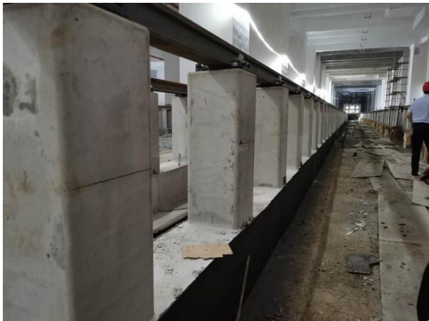
图4-3 装配式混凝土小立柱
