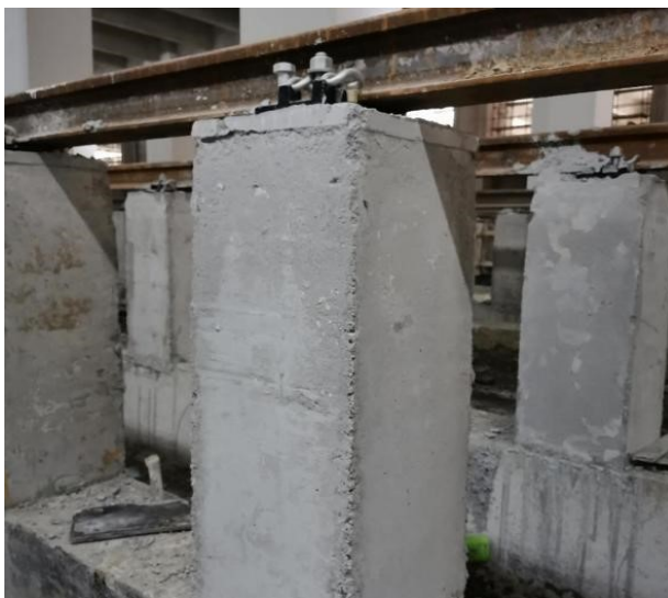
图4-4 现浇混凝土立柱
