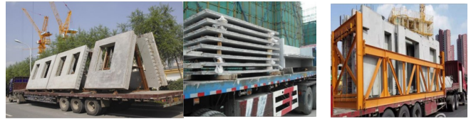
图2 混凝土构件到场
