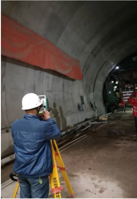
图1 监理抽检洞口测量监控数据
