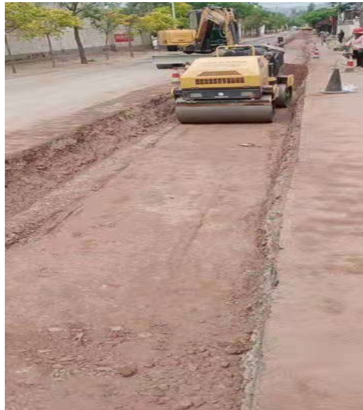
图1 涵管嵌入施工
