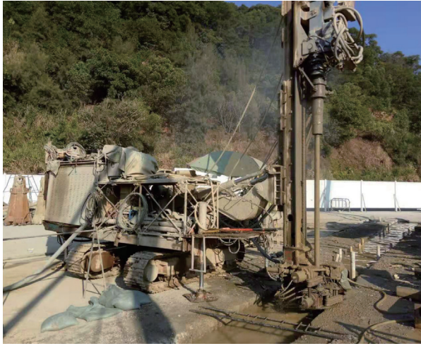
图4 潜孔钻机钻孔施工
