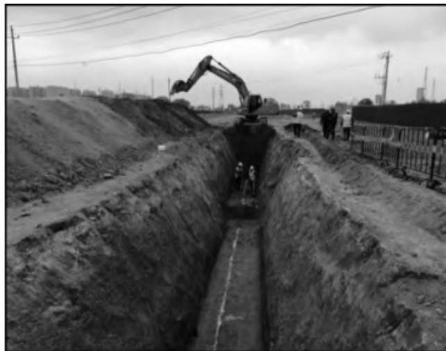
图1 沟槽开挖
