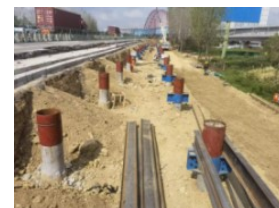
图4 预制板临时支撑
