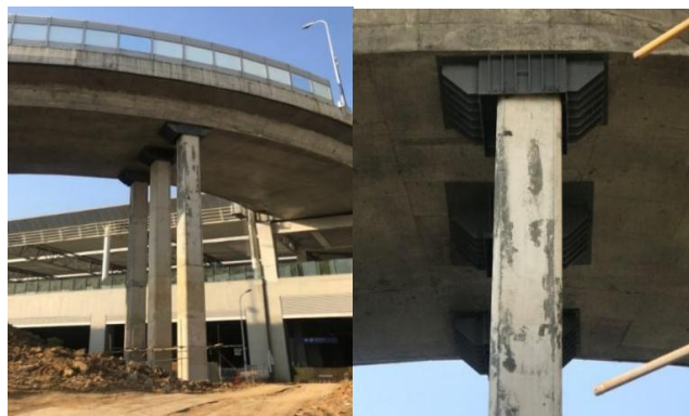
临时钢结构挡块
