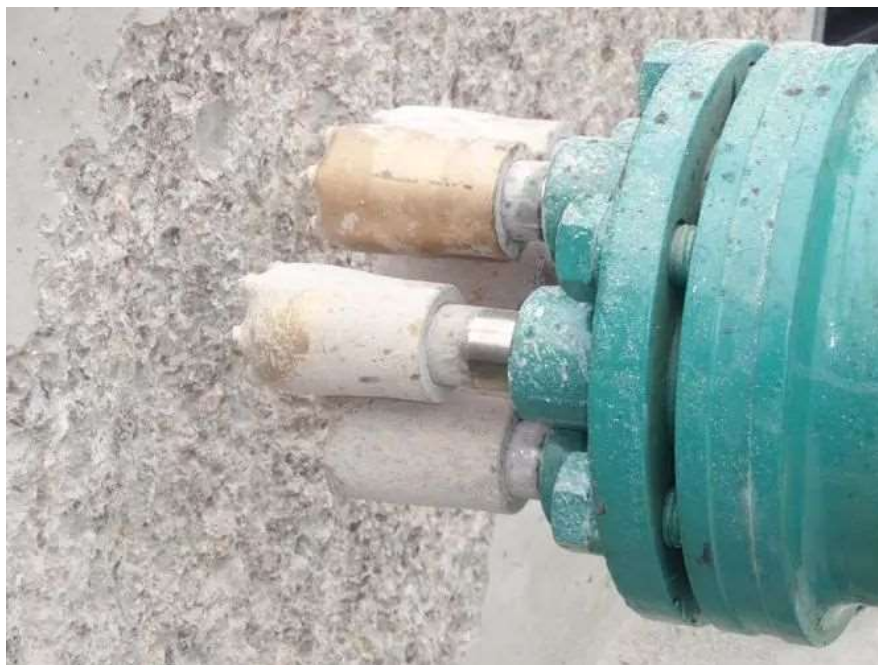
图1 混凝土凿毛
