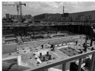
现场支撑布置
