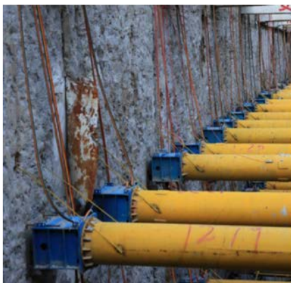
安拆复杂、排管排线、易被破坏
