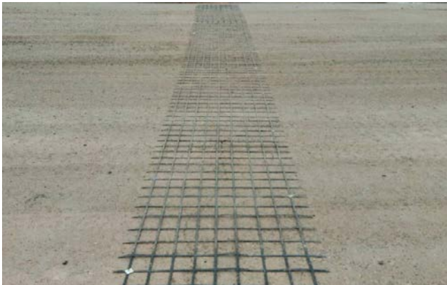
底基层或下基层裂缝处加铺土工格栅
