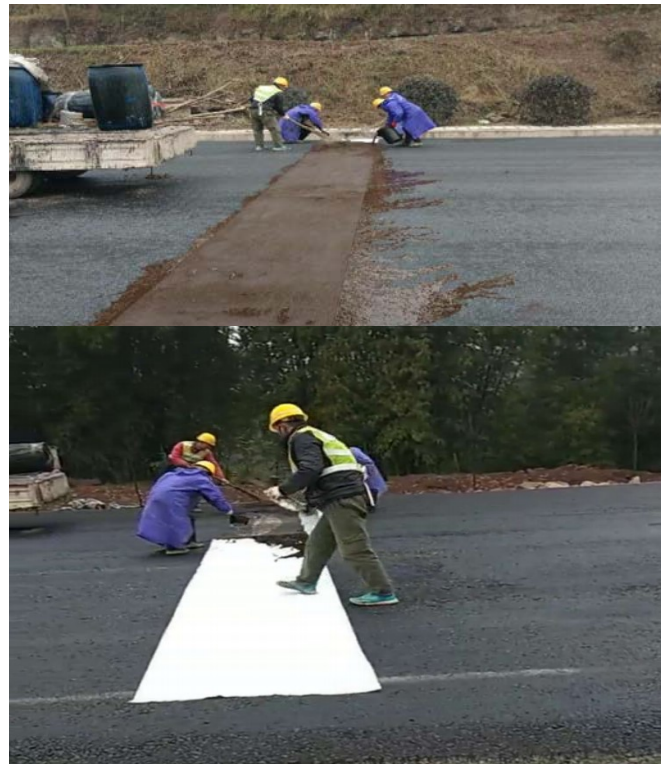
上基层裂缝处加铺聚酯玻纤布
