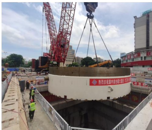
图3 T环整体吊装图
