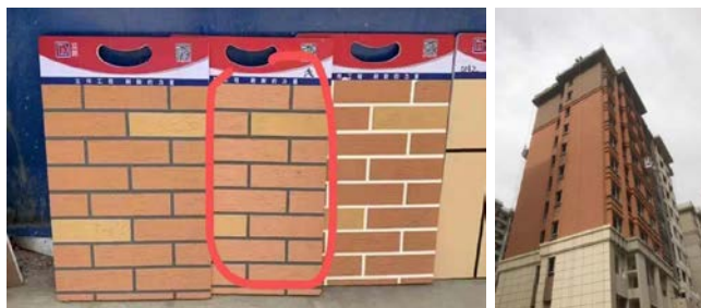
图6 样板上墙的色彩呈现差异
