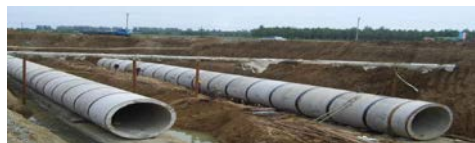
图2 开槽埋管施工
