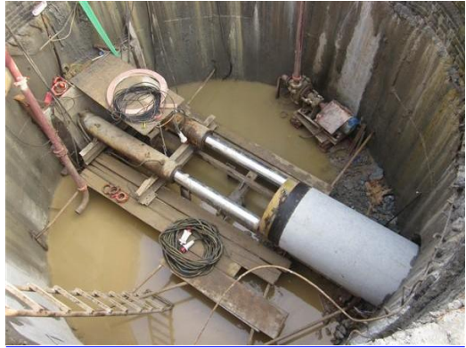
图1 顶管施工
