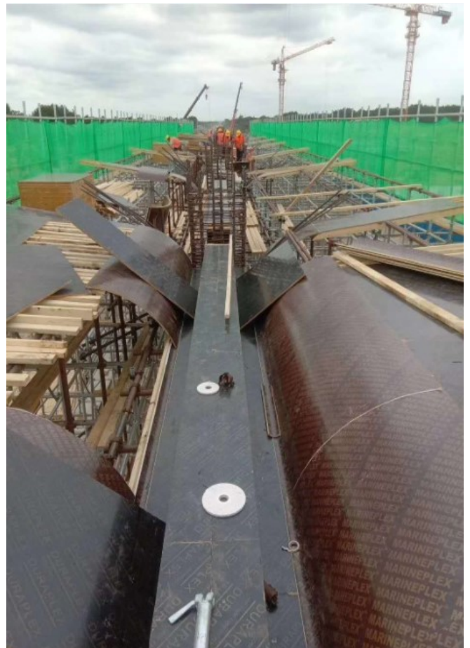
图1 模板施工现场
