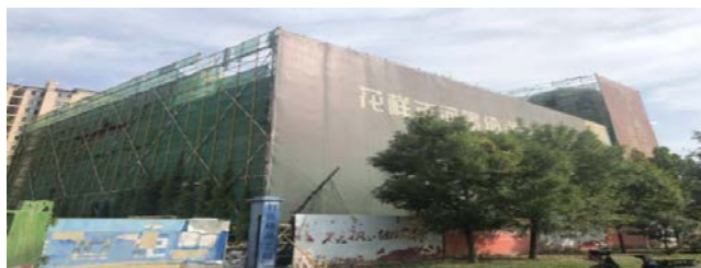
图1 花郡家园配套公建主体完工图
