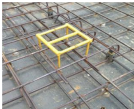
图3 钢筋吊凳安装示意图
