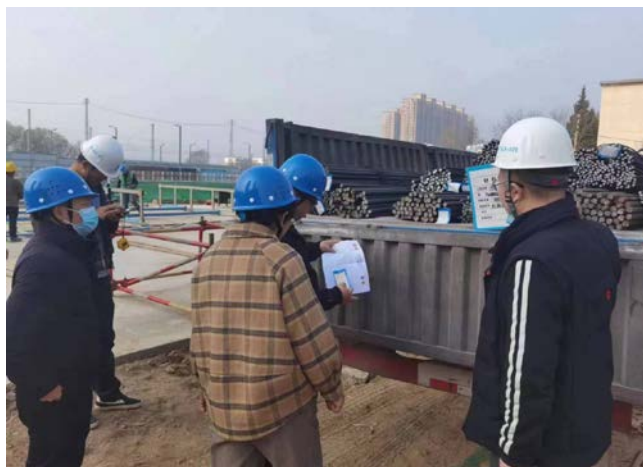
图2 材料进场检验
