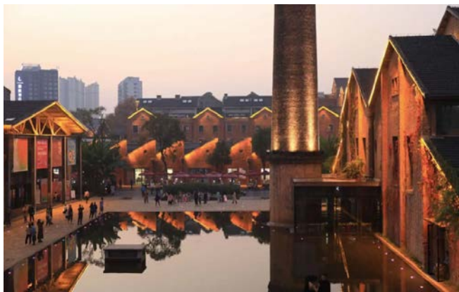
图2 传统元素在建筑屋顶的应用
