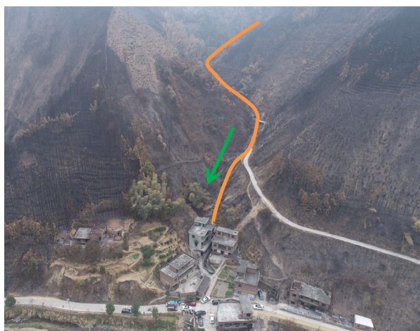
图3 泥石流沟全貌
