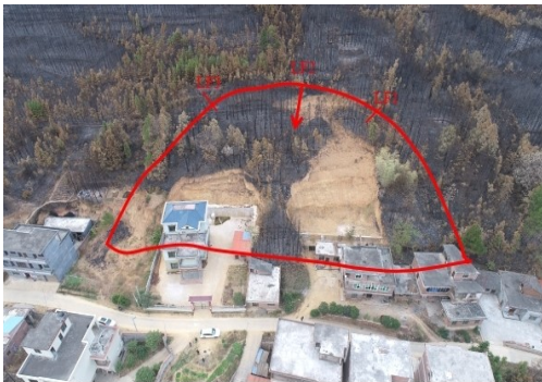
图1 滑坡全貌航拍影像
