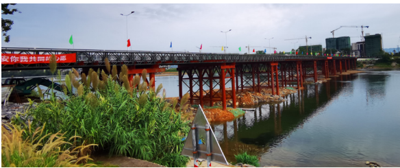
图3 便桥建成实景图
