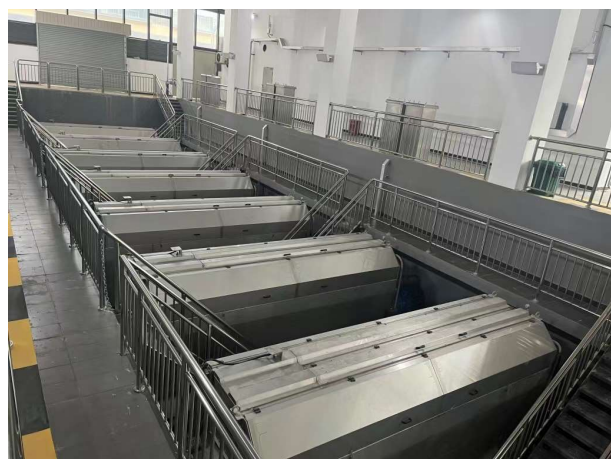
图1 污水厂设备安装（来源：作者自摄）
