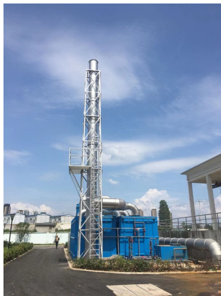
图2 污水厂生物除臭处理设备（来源：作者自摄）
