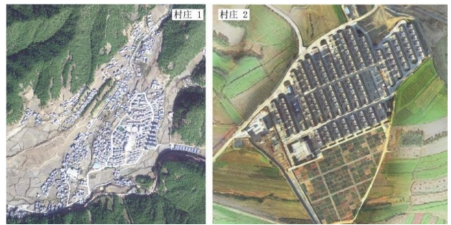
图3 内部道路建设对村庄肌理的影响
