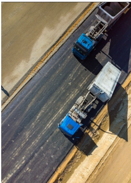
高速公路路面维护
