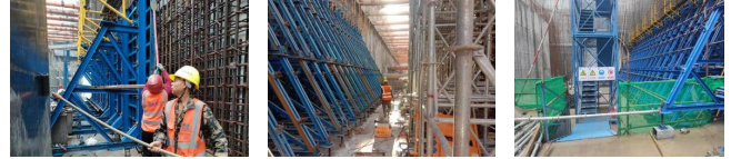
图10 现场侧墙钢模安装、加固
