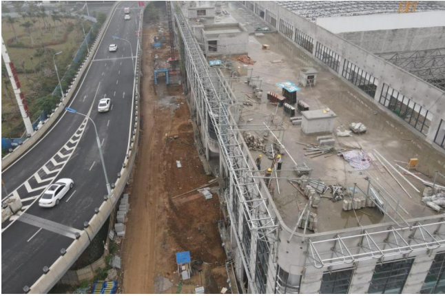
(转角处现场施工照片)
