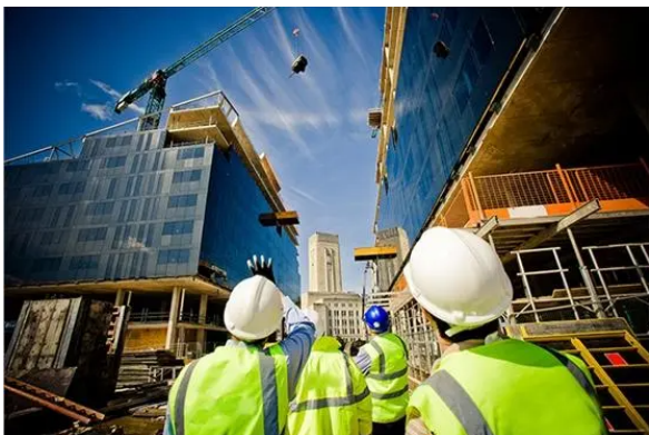
图2 建设工程现场施工图
