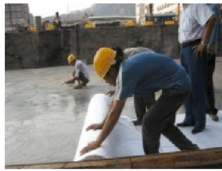
图3-3 混凝土收面覆盖
