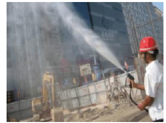
图3-4 设备喷雾养护
