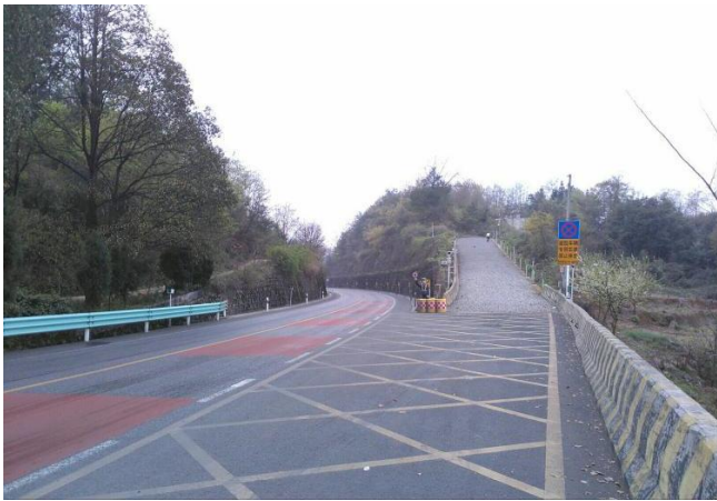
图1 避险车道实景图
