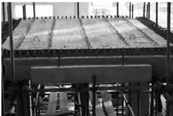
图1 装配式混凝土建筑施工作业现场
