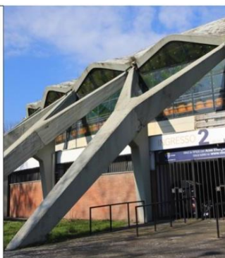
图12 Y形斜柱传力示意图 图13 Y形斜柱（摄影：邢晓萌）
