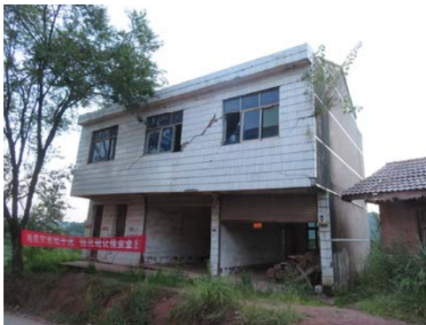
照片 重点勘查区禾梨坳集镇老榨油厂滑坡后缘房屋变形情况
