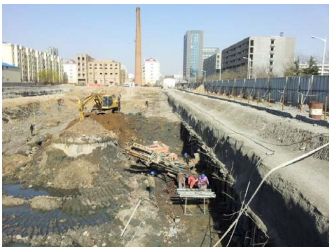
图4 基坑施工实景图
