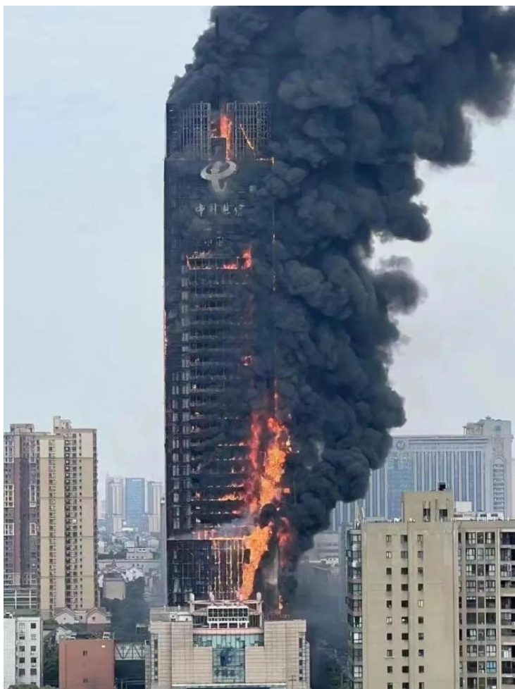
图1 长沙电信大楼火灾现场照片
