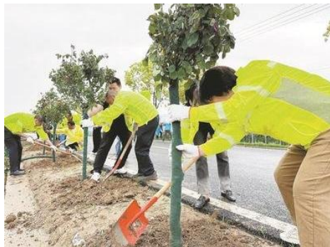
图2 贵州省推进壮美公路建设
