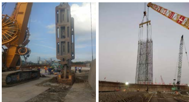
图一：跨河围堰内地墙现场施工图片
