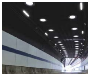
光导管照明案例（洞内）
