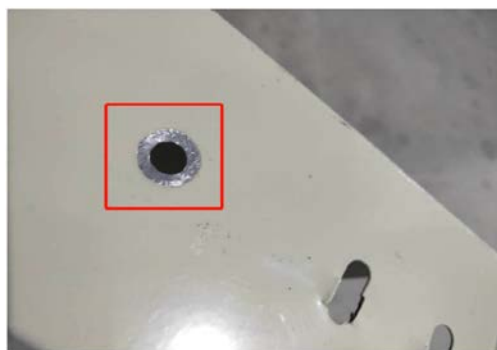
图1 钢制喷涂桥架跨接孔的施工效果图
