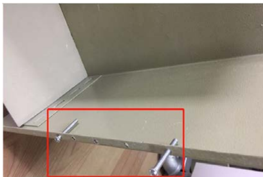
图4 桥架盖板固定孔效果图
