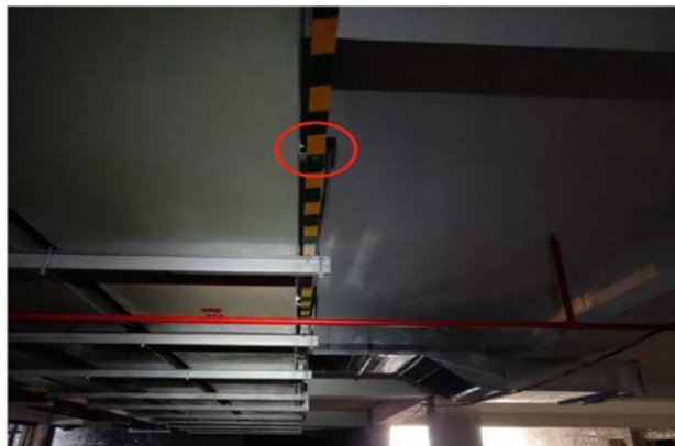
图3 桥架支架跨接效果图
