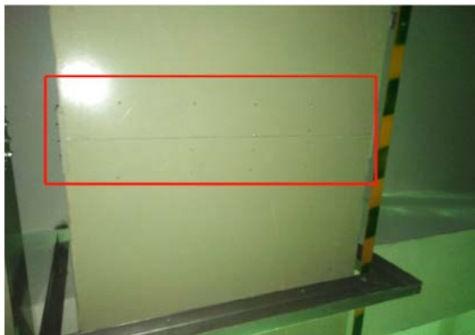
图2 桥架连接处内加钢板效果图
